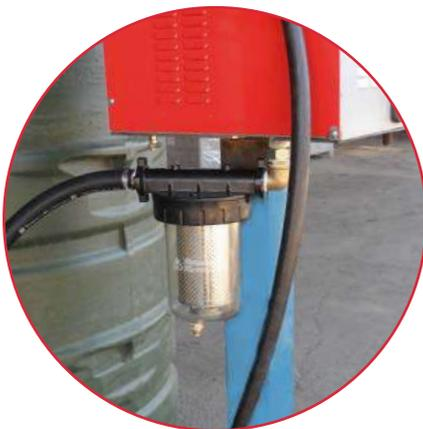
Filtro FG-100 instalado en surtidor controlador GK7
